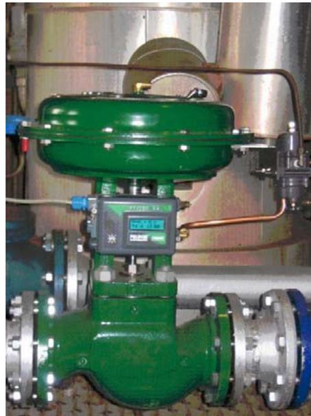
GAMBAR 5. Ilustrasi Level Control Valve
