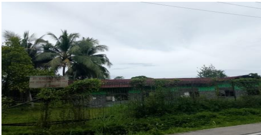
Gambar 2: Potret Pabrik Kelapa Sawit di Arso XII Kabupaten Keerom yang Sudah Tidak Beroperasi
