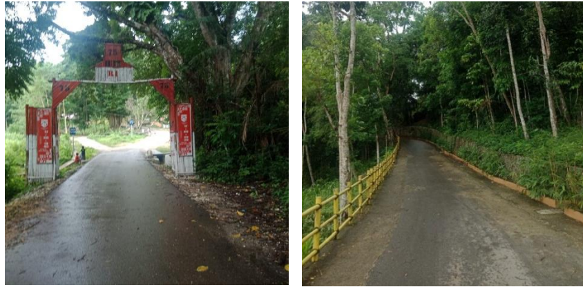
Gambar 5. Kondisi jalan Sumber: Hasil Peneliti
